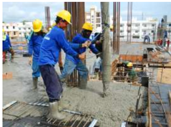
รูปที่ 4.123 การเทคอนกรีตในแบบหล่อพื้นโพสเทนชั่น
