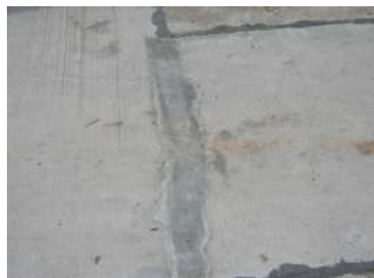
รูปที่ 4.69 การซ่อมรอยร้าวคอนกรีตด้วยซีเมนต์พิเศษสำหรับซ่อมรอยร้าว
