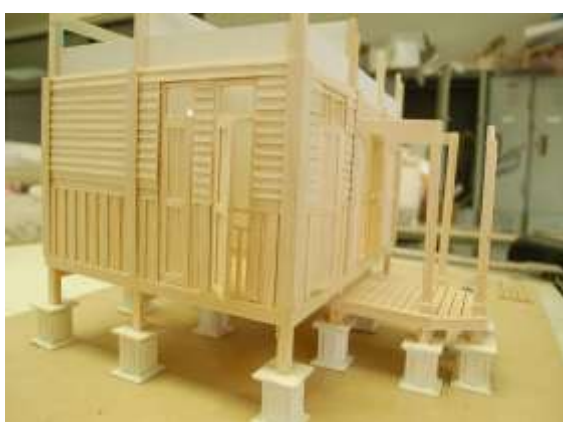
รูปที่ 4.7 แสดงเสา คาน ตง พื้นไม้ ภายนอกกระบียง
