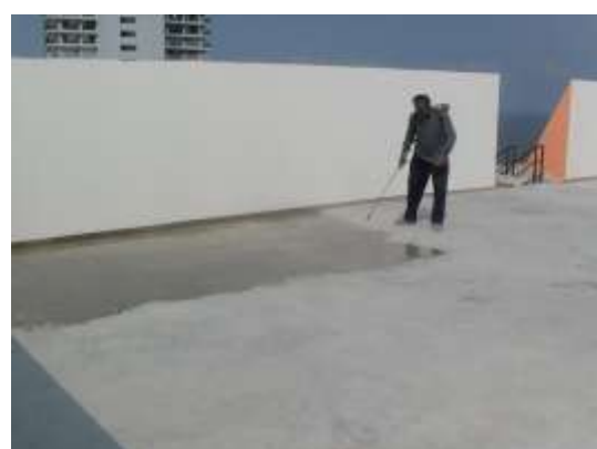
รูปที่ 4.67 การใช้น้ำยาฟนเคลือบผิวหน้าเพื่อ กันความชื้นระเหยตัวเป็นการบ่มคอนกรีต อีกวิธีหนึ่ง
