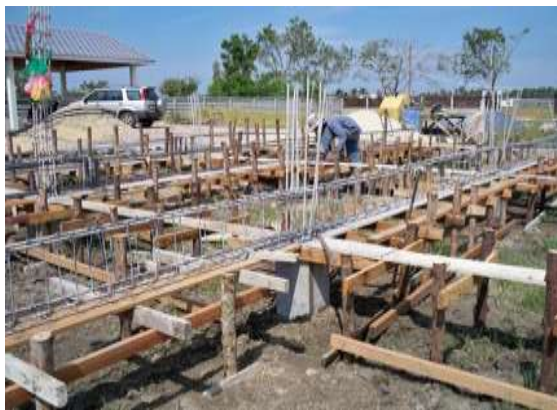
รูปที่ 4.84 การตีแบบท้องคานด้วยไม้
