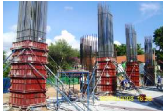
รูปที่ 4.83 การเข้าแบบเสาด้วยแบบเหล็ก
