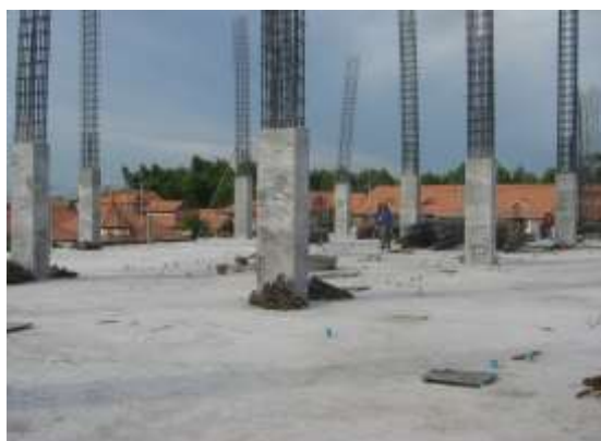
รูปที่ 4.66 การใช้พลาสติกห่อเสาหลังจากแกะแบบออก เพื่อเป็นการป้องกันความชื้นระเหยออกจากคอนกรีตเป็นการบ่มคอนกรีต
