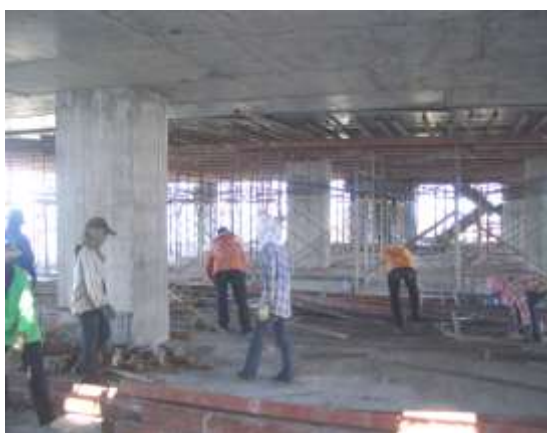
รูปที่ 4.92 การรื้อแบบท้องพื้น
