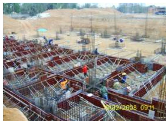
รูปที่ 4.87 การเข้าแบบข้างคานด้วยแบบเหล็ก
