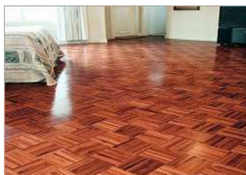
รูปที่ 4.12 พื้นไม้ปาร์เก้ภายในอาคาร
