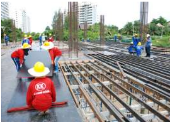
รูปที่ 4.116 การปูไม้แบบบนตงเพื่อเป็นแบบ รองท้องพื้น โปสเทนชั่น
