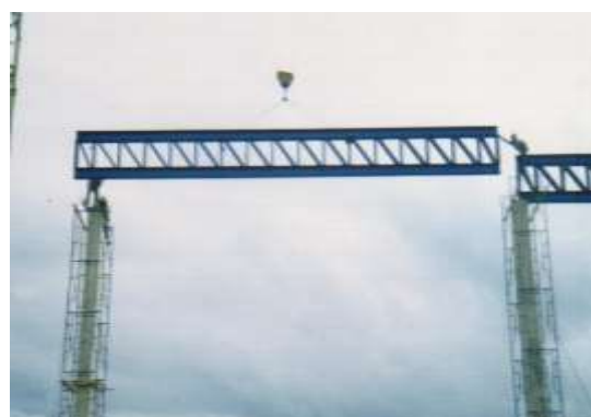
รูปที่ 4.33 การติดตั้งคานประกอบโดยการใช้เครน
