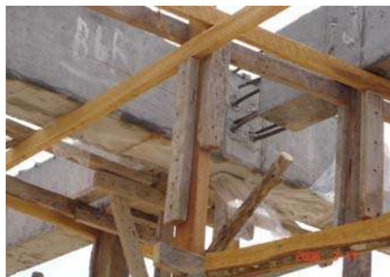
รูปที่ 4.97 การเชื่อมต่อคานสำเร็จรูปที่เป็นคานชอยกับคานสำเร็จรูปที่เป็นคานหลัก
