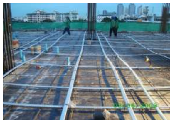
รูปที่ 4.121 ทำความสะอาดตรวจสอบการ หมุนลูกปูนและการวางระดับสลิงก่อนเท คอนกรีต
