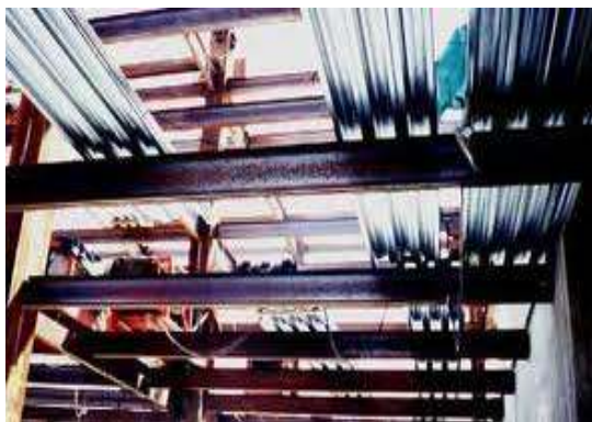
รูปที่ 4.38 ลักษณะโครงสร้างแบบ COMPOSITE ซึ่งในรูปแสดงเสา คาน พื้น เหล็ก
