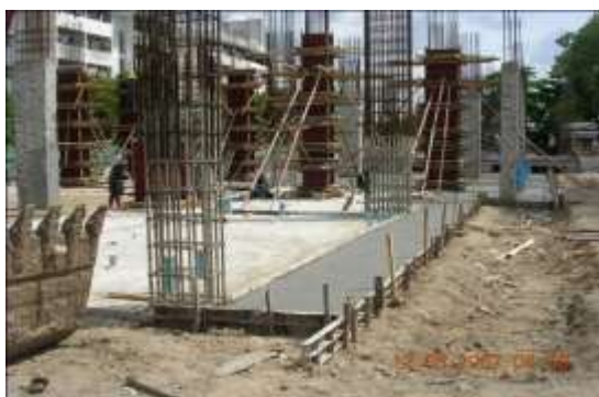
รูปที่ 4.72 การวางเหล็กเสา
