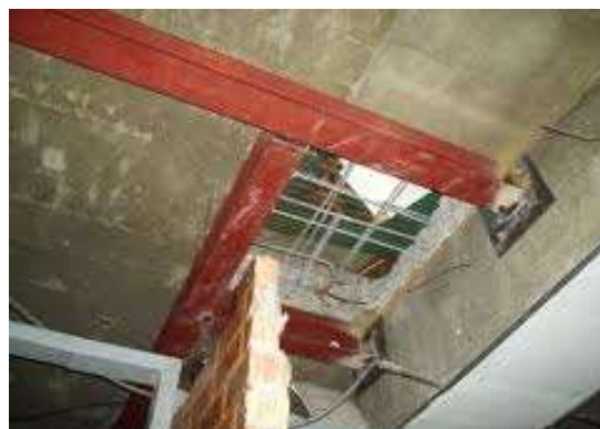
รูปที่ 4.31 การวางแผ่นพื้นคอนกรีตบนคานเหล็ก
