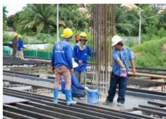
รูปที่ 4.115 การวางตงเพื่อรองรับแบบหล่อ พื้นโพสเทนชั่น
