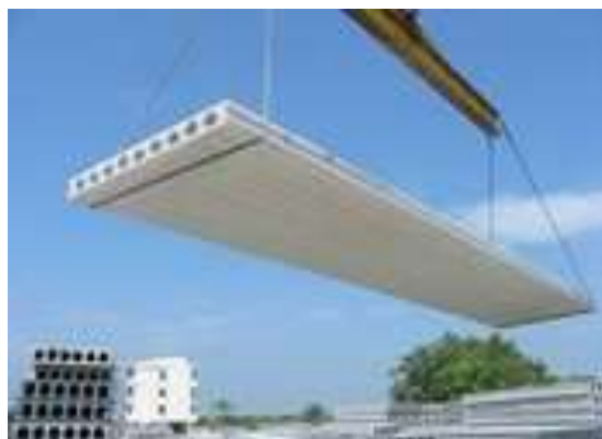
รูปที่ 4.107 การยกพื้นสำเร็จรูปแบบกลวงเพื่อติดตั้ง
