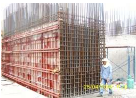
รูปที่ 4.81 การผูกเหล็กผนังลิฟต์
