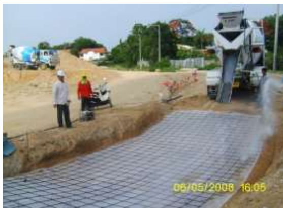
รูปที่ 4.58 การลำเลียงคอนกรีตมายังหน้างาน โดยรถโม้ปูน
