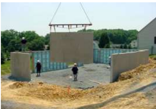
รูปที่ 4.100 การยกติดตั้งผนังคอนกรีตสำเร็จรูป
