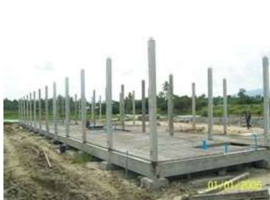
รูปที่ 4.49 ภาพแนวเสาตั้งตรงกันตลอดแนวและไม่ล้มคิง
