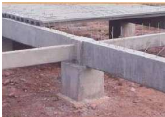
รูปที่ 4.99 หลังจากเชื่อมรอยต่อแล้วต้องตกแต่งให้เรียบร้อย
