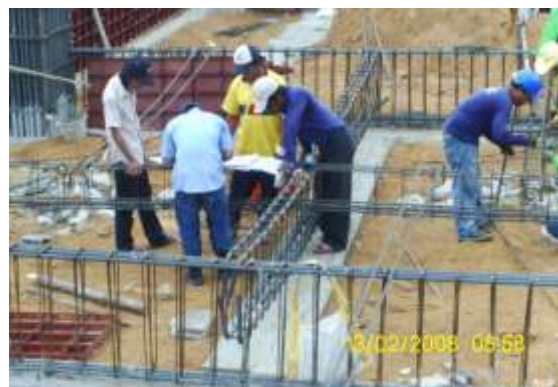
รูปที่ 4.79 การผูกเหล็กคานคอนกรีต
