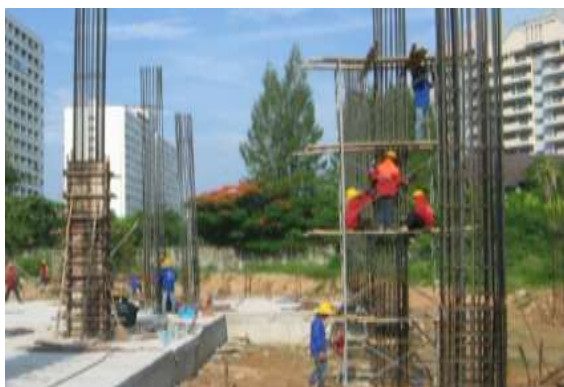
รูปที่ 4.78 การผูกเหล็กปลอกเสาคอนกรีต
