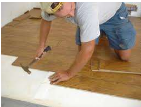
รูปที่ 4.13 การปูพื้นไม้ไม่ต้องอัดให้สนิท
