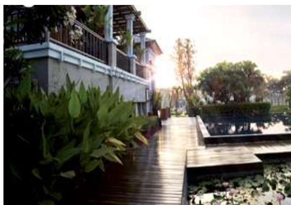
รูปที่ 4.18 การปูไม้พื้นจริงภายนอกอาคาร
