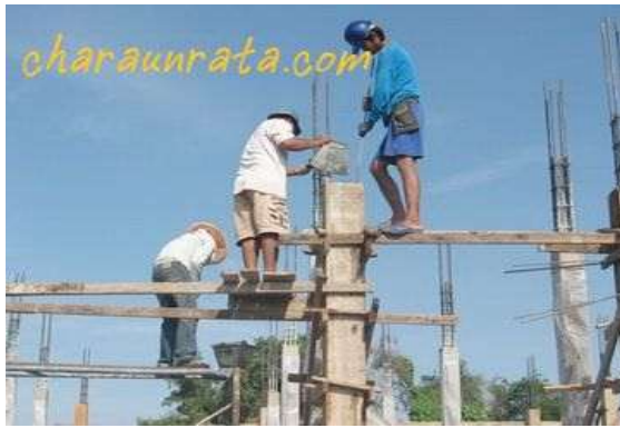
รูปที่ 4.82 การเข้าแบบเสาด้วยแบบไม้
