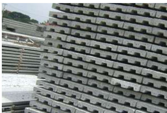
รูปที่ 4.104 พื้นสำเร็จรูปแบบสามขา
