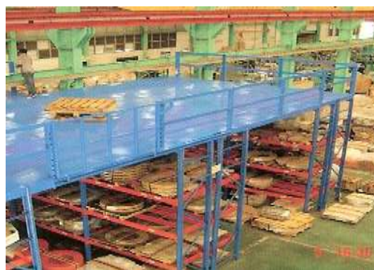
รูปที่ 4.39 พื้นเหล็กตะแกรง ในโรงงาน อุตสาหกรรม
