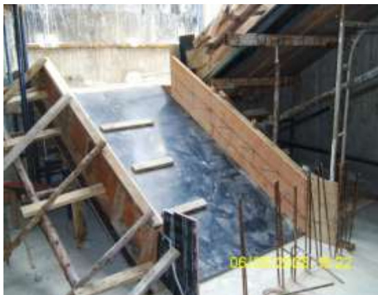
รูปที่ 4.88 การเข้าแบบห้องบันได คสล.
