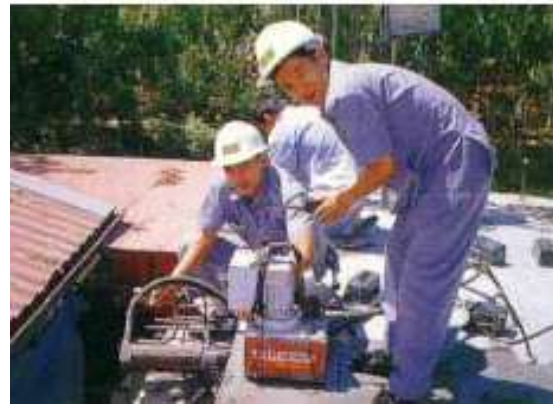
รูปที่ 4.127 ทำการดึงสลิ่งด้วยเครื่องไฮดร ลิกส์ให้ได้กำลังตามที่กำหนด
