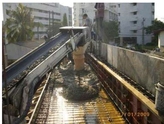
รูปที่ 4.63 การเทคอนกรีตด้วยสายพาน (BELT CONVEYORS)
