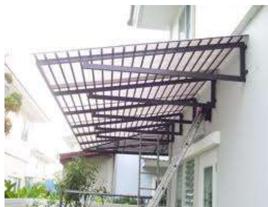
รูปที่ 4.33 กันสาดโครงหลังคาเหล็ก
