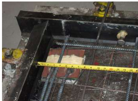
รูปที่ 4.109 ตรวจสอบท่อปะปา ท่อไฟฟ้าในคอนกรีตให้ได้ตามแบบก่อสร้าง
