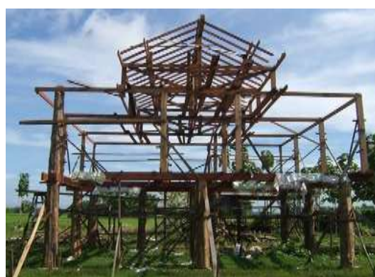
รูปที่ 4.4 บ้านโครงสร้างไม้ทั้งหลัง
