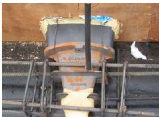
รูปที่ 4.120 การวางหัว Anchorages
