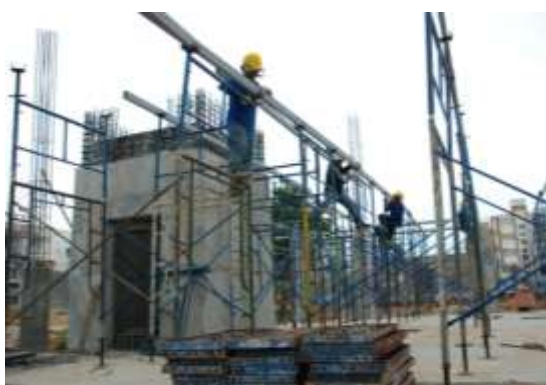
รูปที่ 4.114 การตั้งนั่งร้านเหล็กเป็นค้ำยัน ท้องแบบหล่อพื้นโพสเทนชั่น
