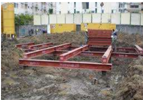
รูปที่ 4.30 การวางคานเหล็กรูปพรรณ ที่ใกล้ความขึ้นต้องทาสีกันสนิม
