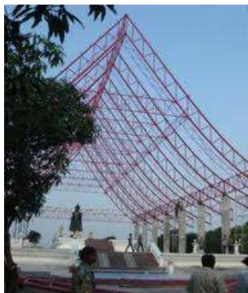
รูปที่ 4.45 โครงหลังคา (Truss) เหล็กรูปจั่ว
