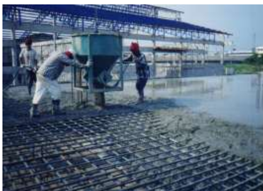
รูปที่ 4.53 การเทคอนกรีตพื้นประเภทฝากน้ำหนักบนคาน (Slab on beam)
