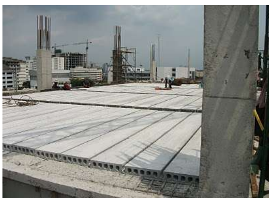
รูปที่ 4.106 พื้นสำเร็จรูปแบบกลวง (Hollow Core)
