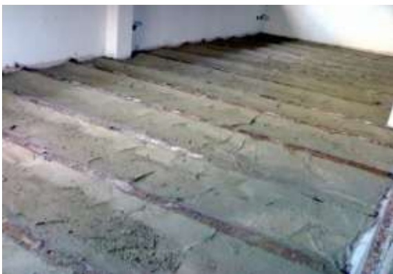
รูปที่ 4.15 การวางตงบนพื้นคอนกรีต
