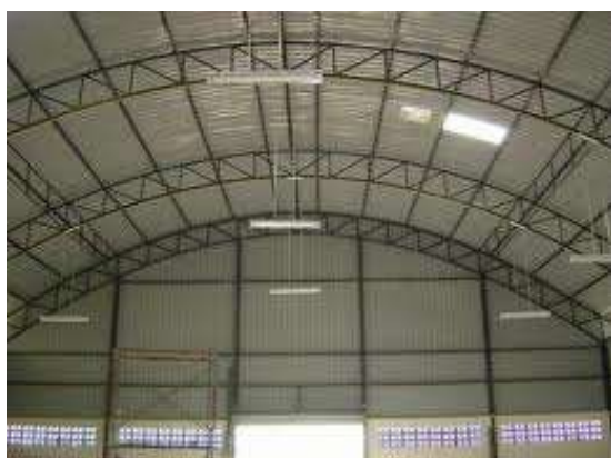
รูปที่ 4.42 โครงหลังคาเหล็ก (Truss) ทรงโค้ง
