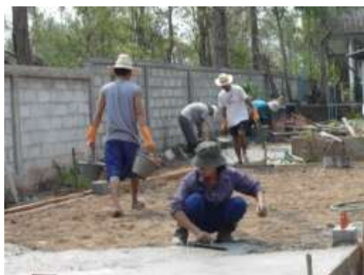
รูปที่ 4.54 การเทคอนกรีตพื้นประเภทฝากน้ำหนักบนพื้นดิน (Slab on ground)
