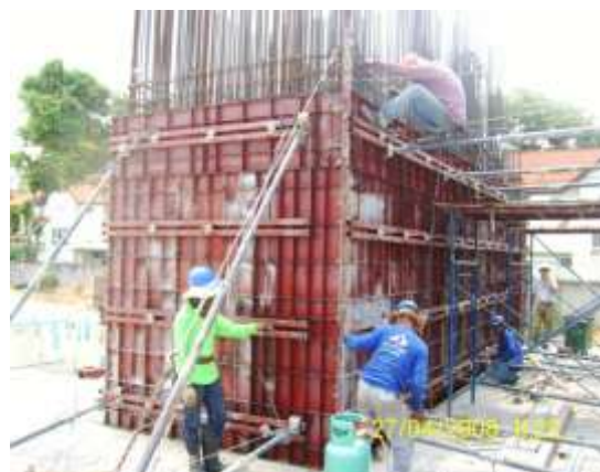
รูปที่ 4.89 การเข้าแบบข้างผนังลิฟต์
