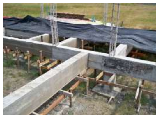
รูปที่ 4.52 การแกะแบบข้างคานและตรวจว่ามีโพรงในคอนกรีตหรือไม่ ส่วนแบบท้องคานต้องให้คอนกรีตได้อายุตามที่กำหนดจึงสามารถแกะแบบได้
