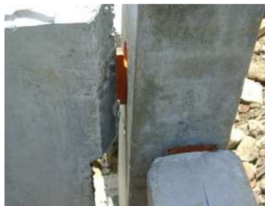
รูปที่ 4.113 ตรวจสอบรอยเชื่อมให้ได้ขนาด และมีการทาสีกันสนิม ไม่ว่าจะด้วยระบบใด
