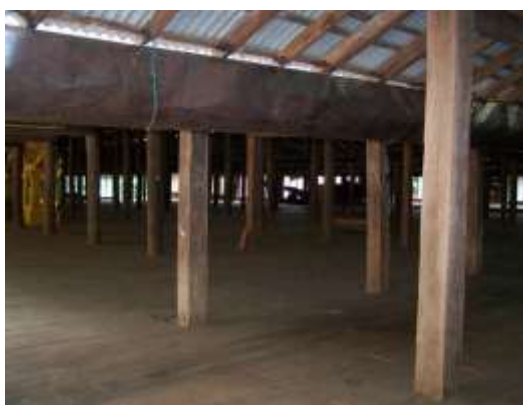
รูปที่ 4.1 เสาไม้หน้าตัดสี่เหลี่ยม
