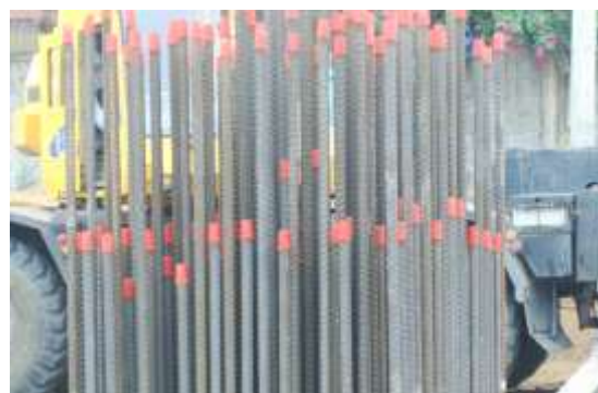
รูปที่ 4.73 การเตรียมต่อเหล็กเสาโดยวิธี Coupler
