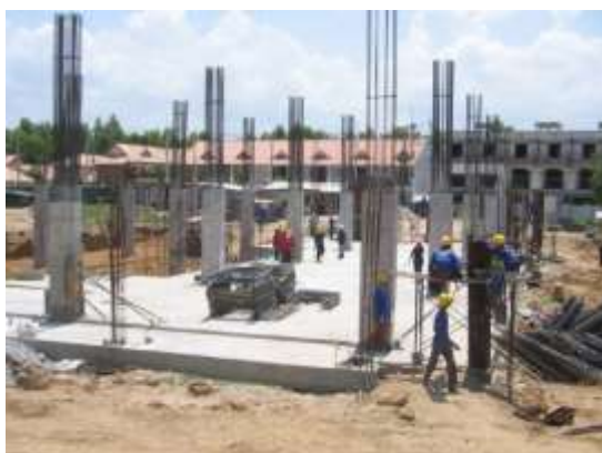
รูปที่ 4.48 ภาพเหล็กเสริมของเสา คสล.
