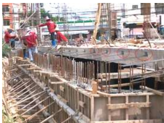
รูปที่ 4.124 แสดงการวางสลิงให้ยาวออกมาจากพื้น เพื่อทำการดิ่งสลิง
