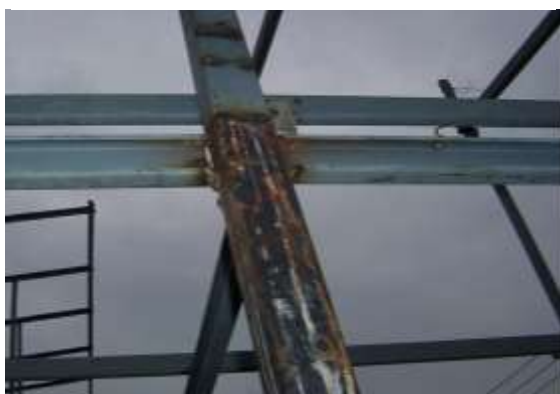
รูปที่ 4.28 ต้องตรวจเช็ครอยเชื่อมให้เต็มและ สึกกันสนิมก่อนทาสีจริง
