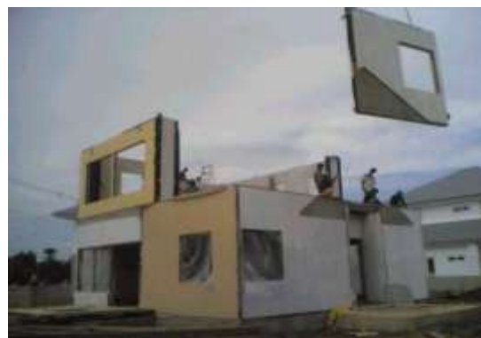
รูปที่ 4.101 การยกติดตั้งผนังคอนกรีตสำเร็จรูป (แบบเจาะรูปประตูหรือหน้าต่าง)
