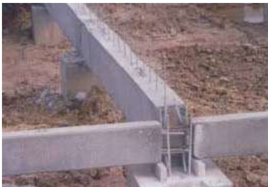
รูปที่ 4.98 การเชื่อมรอยต่อระหว่างคานต้องเทคอนกรีตเพื่อเชื่อมต่อกัน
