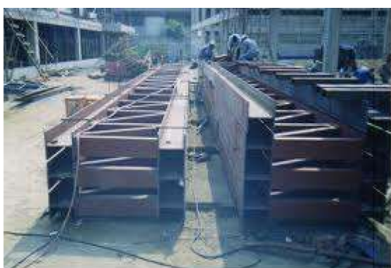
รูปที่ 4.32 การทำคานประกอบบริเวณพื้นที่ก่อสร้าง เพื่อสะดวกในการยกขึ้นติดตั้ง
