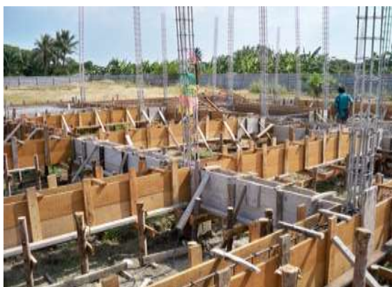
รูปที่ 4.86 การเข้าแบบข้างคานด้วยแบบไม้
