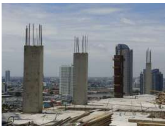
รูปที่ 4.50 การแกะแบบเสาคอนกรีต
