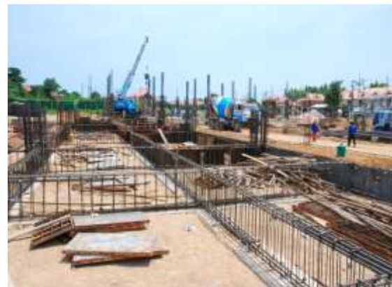
รูปที่ 4.85 การเทคอนกรีตลึน เป็นแบบรอง ท้องคาน สำหรับคานทวางอยู่บนดิน
