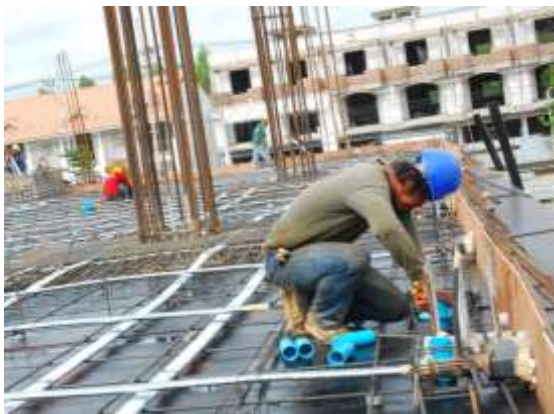
รูปที่ 4.118 การวางสลิงรับกำลังของพื้นโปส เทนชั่น
