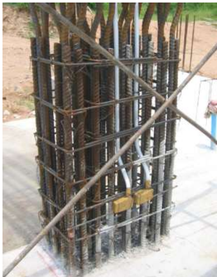
รูปที่ 4.76 การเตรียมต่อเหล็กเสาโดยวิธีการ ทาบเหล็ก
