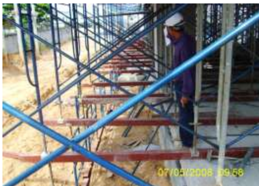
รูปที่ 4.90 แสดงการใช้นั่งร้านเป็นเสารับกำลังห้องแบบพื้นหรือคานในแนวตั้ง
