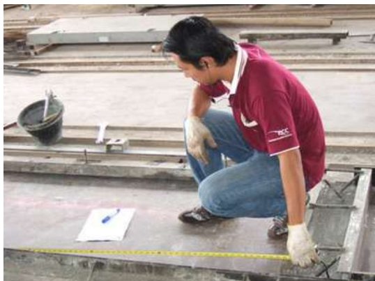
รูปที่ 4.108 การตรวจสอบต้องให้ได้ขนาดตามที่ระบุไว้ในแบบ อยู่ในขั้นตอนตรวจสอบในโรงงานที่ผลิต
